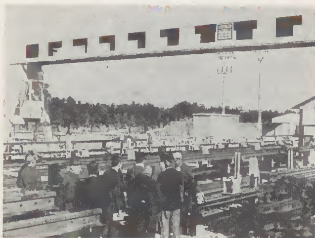
Pórtico P, Alimentação da prensa «destorcimento»
