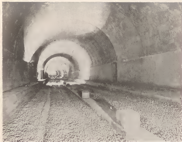
Uma secção em construção do troço Etoile-Auber
