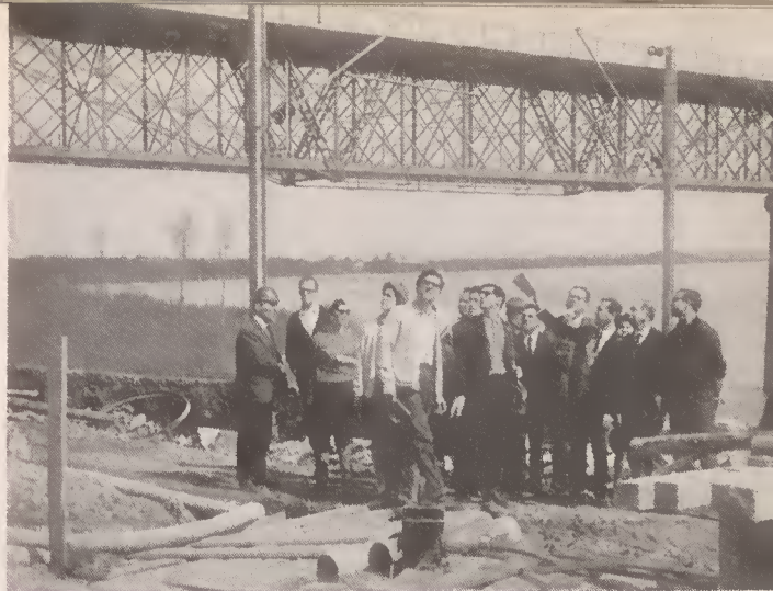
Um grupo de estudantes — alunas e alunos — da cadeira de geomorfologia da Faculdade de Ciências do Porto num momento da sua visita aos estalheiros das obras da C. P. nas encostas de Santarém. Ao fundo, a ponte rodoviária D. Luís
