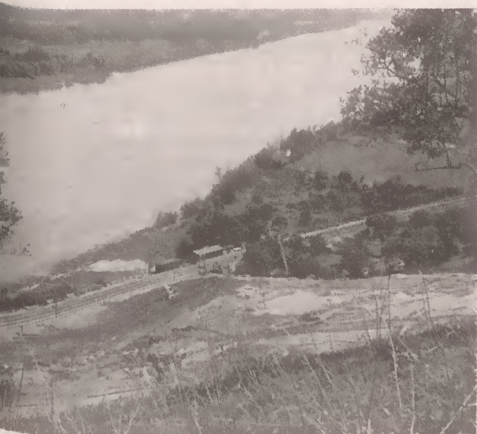
Outro aspecto da encosta do Outeiro da Forca, divisando-se ao fundo o caminho de ferro
