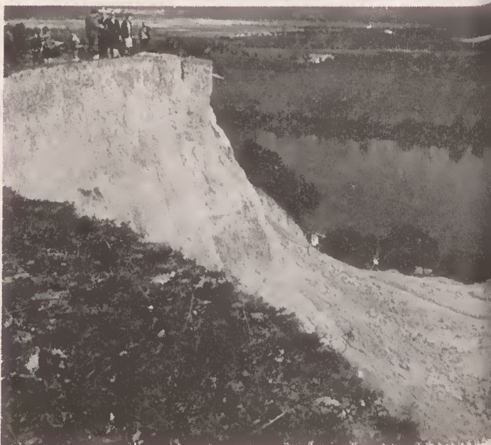
Outeiro da Forca, onde extensos trabalhos de terraplanagem e de consolidação estão sendo operados activamente pela C. P. e pelo L. N. E. C. — e onde se produziu o maior escorregamento de terras, em extensão e volume, de que há notícia em Portugal
