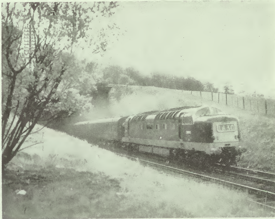
O trabalho de 55 locomotivas rápidas a vapor é realizado, nas melhores condições, por 22 destas máquinas diesel eléctricas «Deltic», actualmente em serviço entre Londres e a Escócia
