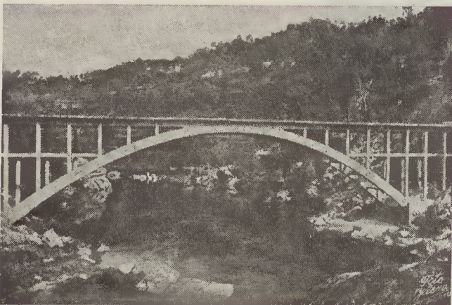
OLIVEIRA DE FRADES — Ponte Luís Bandeira
