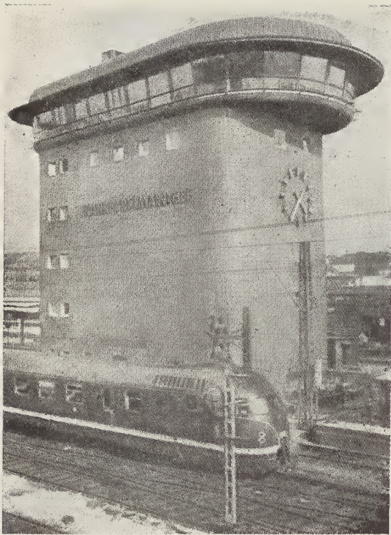
O posto central de sinalização de agulhas e sinais, dos Caminhos de Ferro Alemães, na estação de Francfort, recentemente construído em linhas modernas e ousadas. Esta, como muitas outras construções similares, faz parte de um conjunto de remodelações que os caminhos de ferro germânicos estão operando, em larga escala, em toda a sua rede, com vista ao aperfeiçoamento constante dos seus serviços.
