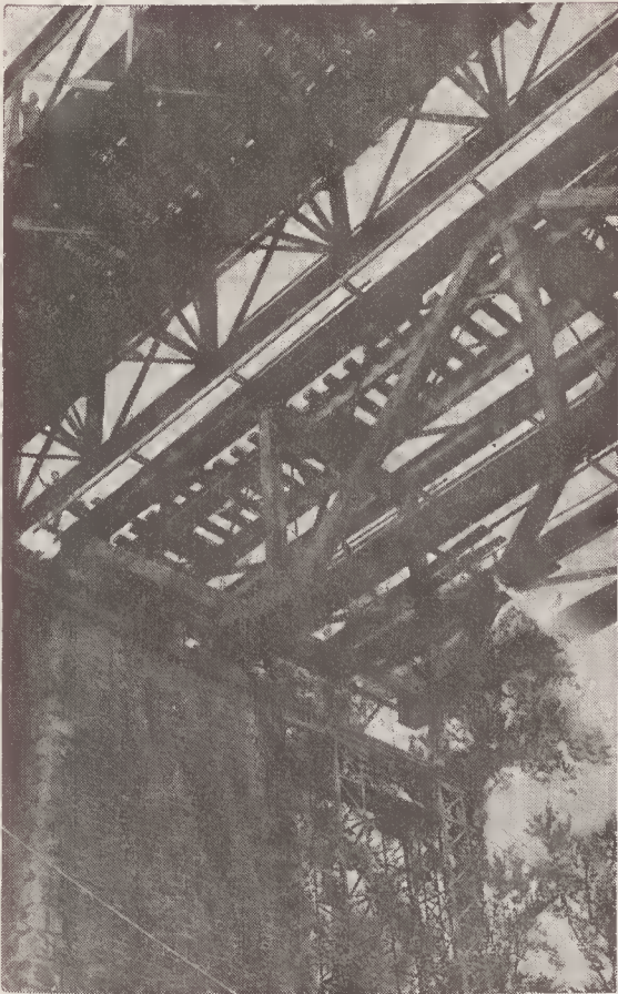
Um aspecto da deslocação do enorme tabuleiro metálico da nova ponte
