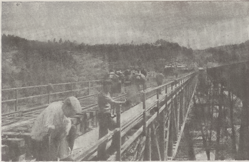
■ Uma brigada de operários procede aos trabalhos de ripagem ■
