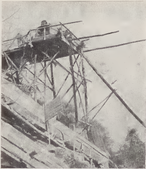
Estaleiro de margem A seta indica o tubo de descida do betão
