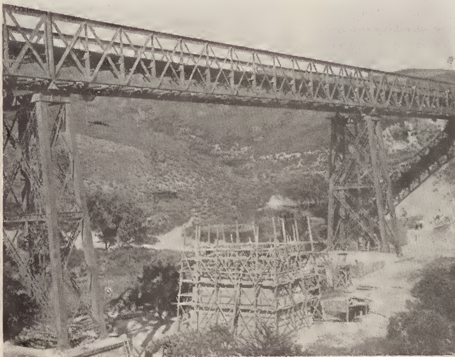
Antiga ponte da Breda. 1.ª fase da betonagem do pilar central.
