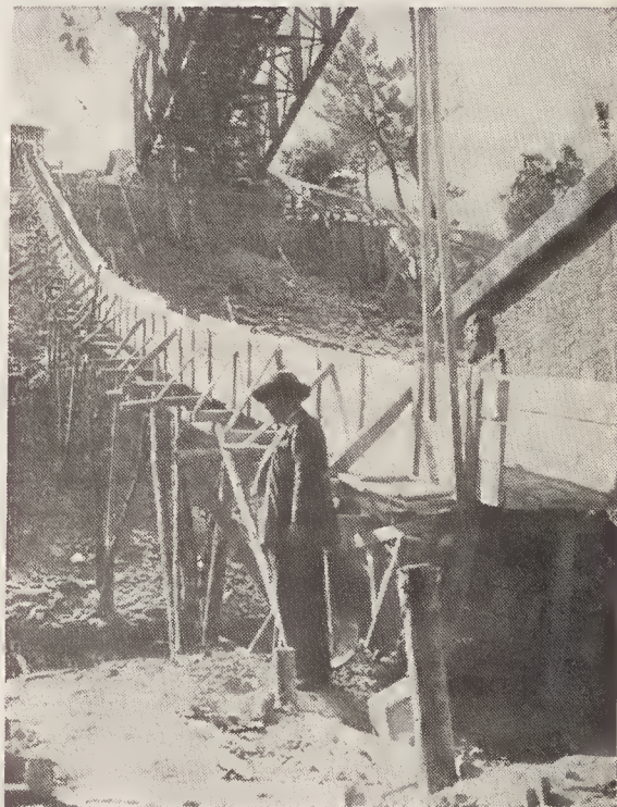
Caleirote para descida de materiais No cimo, o carro carregado pronto a descer — No documentário «100 anos de Caminhos de Ferro» vê-se um pormenor desta descida de materiais na ponte do Criz — Encarregado Geral dos trabalhos — C/mestre principal V. O. José Gaspar
