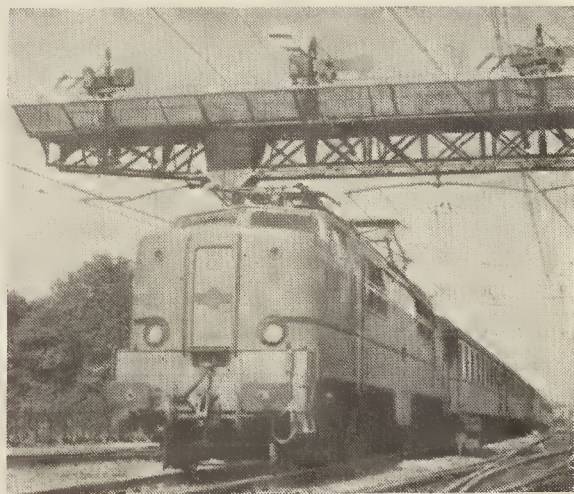
Comboio internacional de tracção eléctrica
