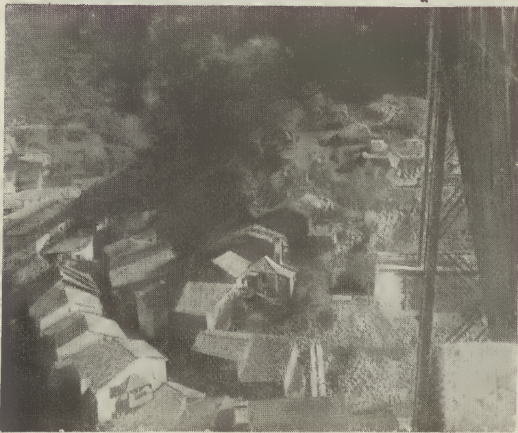
Aspecto da Povoação do Trezói sita sob a ponte. Vêm-se as bases de alguns cavaletes de montagem e reforço do envazamento do pilar P,
