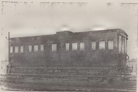
As velhas e pesadas carruagens do serviço suburbano que a Companhia pretende substituir
