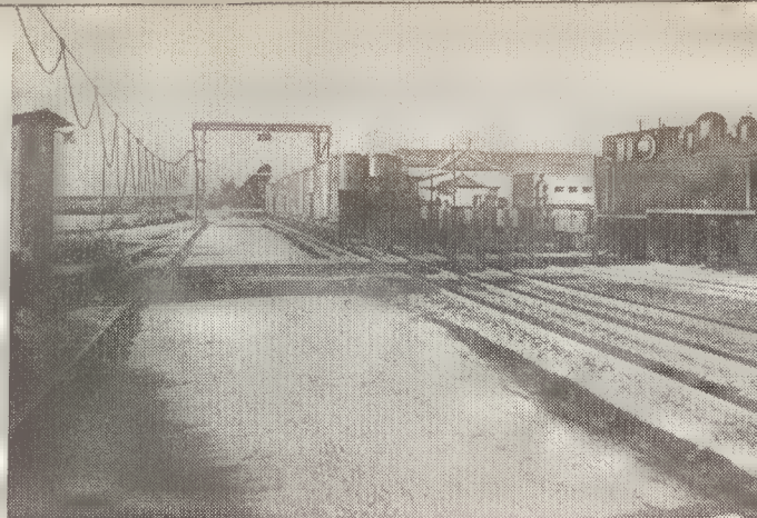
1 — Composição de vagões contentores sob o pórtico de Sendim
