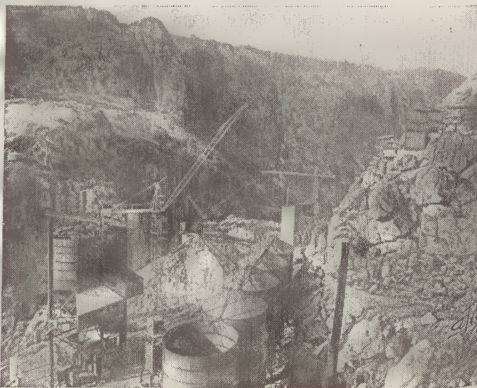
3 — Silos de armazenamento de cimento
