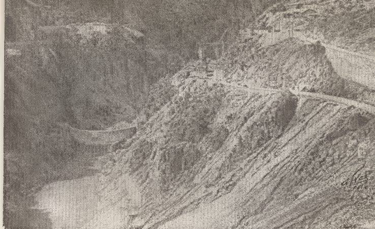
5—Ensecadeira de montante junto da galeria de derivação das águas do Douro
