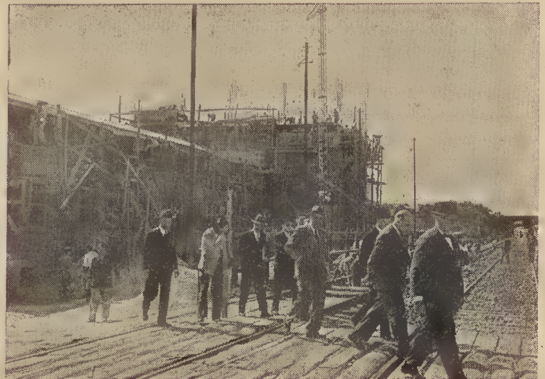
Durante a visita do sr. Prof. Mário de Figueiredo à subestação de Moscavide.
