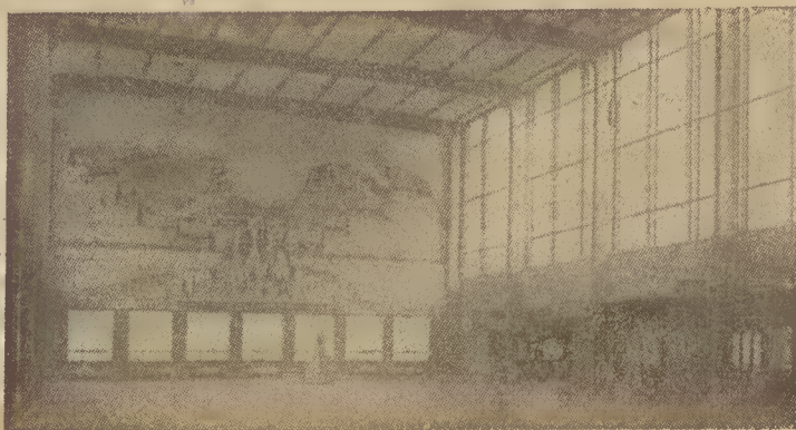
Aspecto interior da estação ferroviária de Amsterdão
