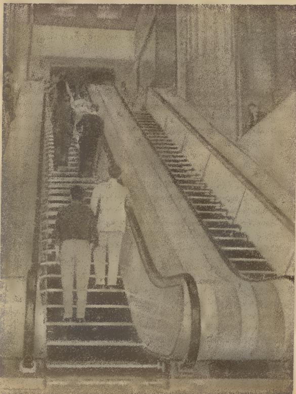
*Escadas - rolantes recentemente instaladas na estação central de Milão e construídas segundo a técnica mais moderna. Têm a capacidade de transporte para 8.000 pessoas, por hora, aproximadamente. Com esta inovação e fazendo uso dos ascensores que a estação já possuía, torna-se possível dar breve vazão aos 160 000 passageiros que, diariamente, afluem à estação central de Milão.*
