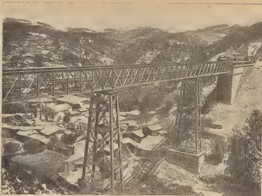
PONTE DE TREZOI - Foto F. Gonçalves
