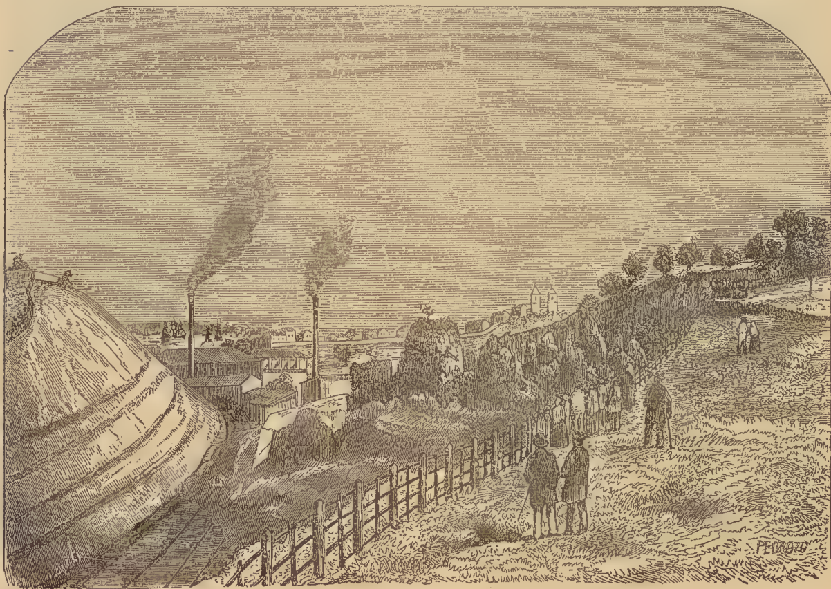
O TERCEIRO DESABAMENTO DA RAMPA DO CORTE DE XABREGAS
