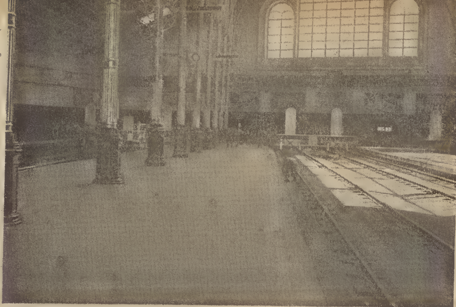
Aspecto da estação do Rossio, após as obras de renovação e beneficiação
