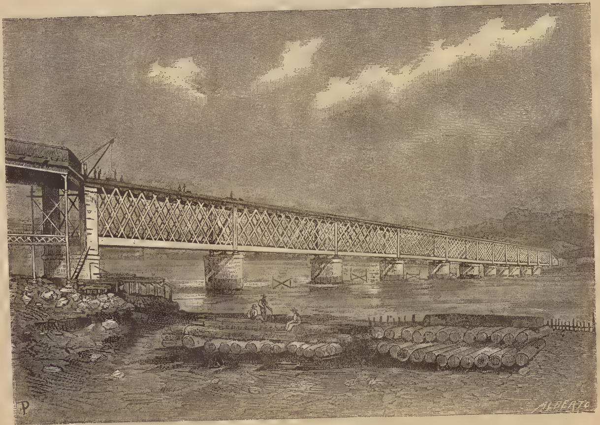
Ponte metálica sobre o rio Lima, inaugurada no dia 30 de Junho de 1878
