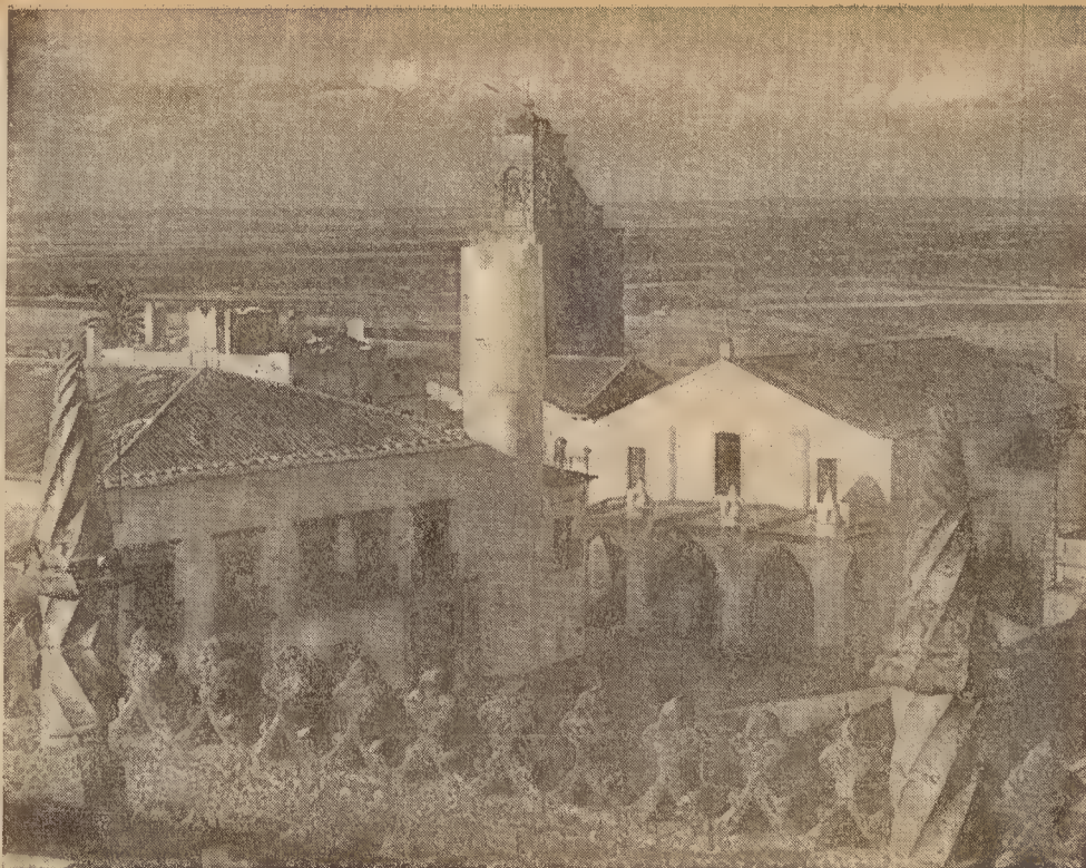
Do telhado da igreja da Conceição vê-se a igreja de Santa Maria e, ao fundo, a infindável planície alentejana
