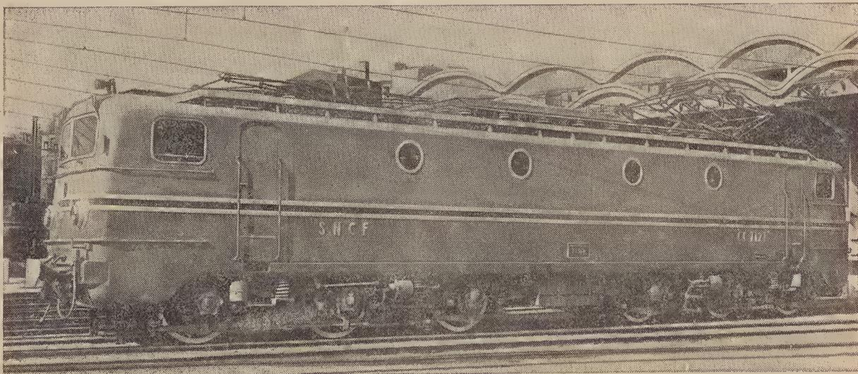
A locomotiva eléctrica francesa CC 7121, de série, construída nas oficinas Alsthom, que rebocando uma composição de 8 carruagens com um peso total de 111 toneladas, atingiu, num troço da linha Paris-Lyon, em Fevereiro de 1954, a velocidade de 243 km/h — máximo mundial de velocidade em caminho de ferro
