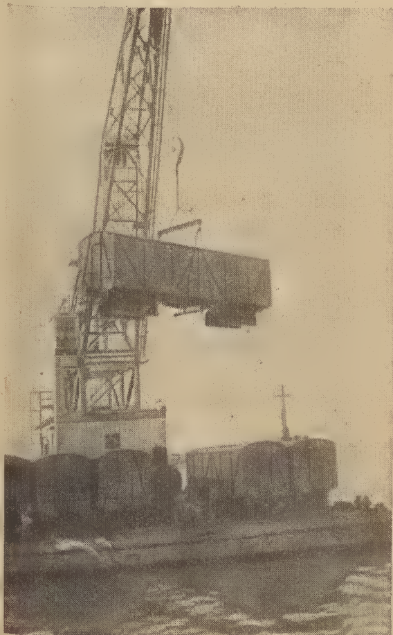
A cabrea «Eng. Espregueira Mendes» transportando 6 vagões para embarque
