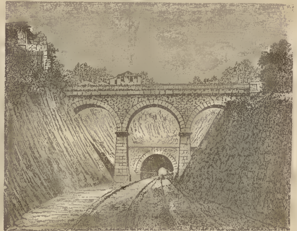
Túnel da Serra do Pilar
