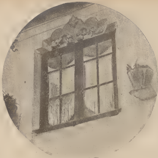
FREIXO DE ESPADA-À-CINTA — Uma janela na vila, ladeada de mísulas para vasos de flores
