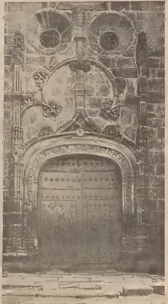
FREIXO DE ESPADA-À-CINTA — Porta principal da Igreja-Matriz
