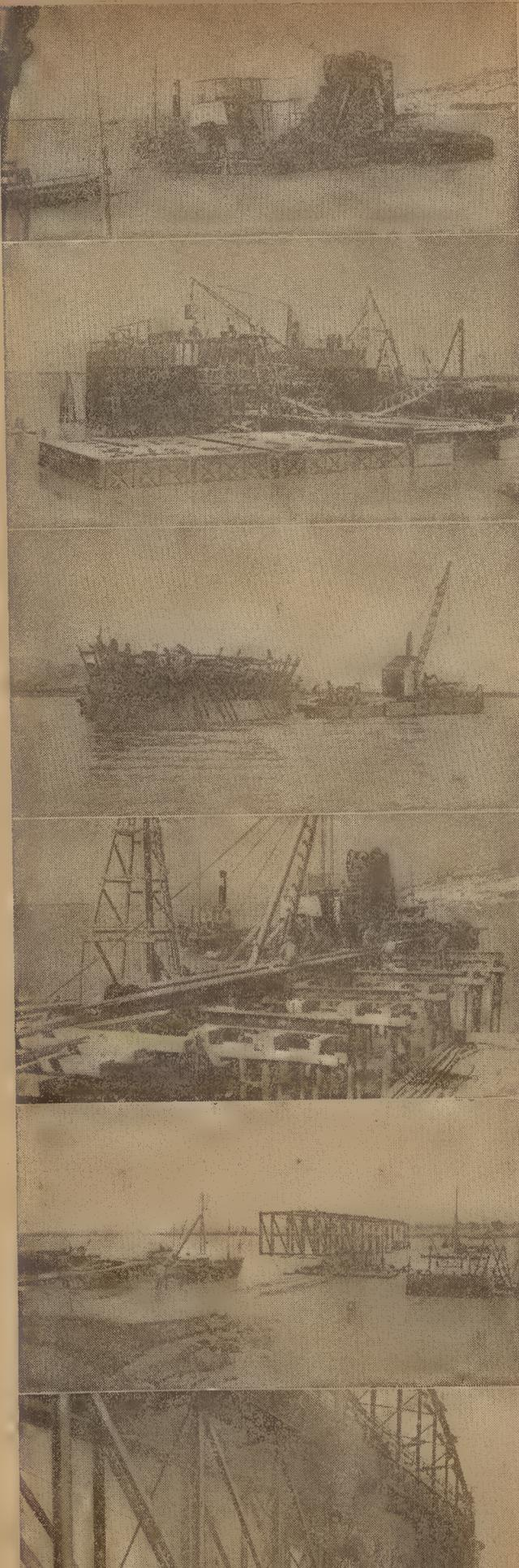
obra, que consta duma parte central constituída por cinco tramos metálicos com o vão de 103.50 metros cada um, e de dois viadutos de betão armado, um em cada margem com a extensão, respectivamente, de 460 ms. na margem direita e de 240 ms. na esquerda, os quais são continuados por ateiros de acesso. A faixa de rolagem tem a largura de 9 metros e é ladeada por dois passeios, cada um com 1,50 ms.
