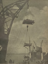
Il sistema di sollevamento a cavi per il trasporto di carichi pesanti in mare aperto. (Marelli/Anip)
