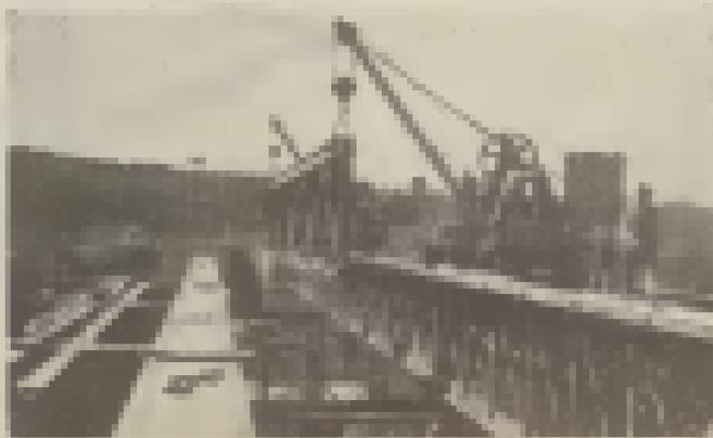
Montaje con un gran puente de construcción de una viga de base de acero de 180.
