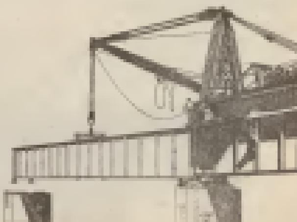
Um dos componentes metálicos da ponte, sendo levantado por uma grua.
