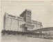
Uma das obras de concreto armado construídas no departamento de Obras. Um exemplo de boa aplicação para as estruturas.
