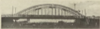
PUENTE DE ACEROS EN EL ESTADO DE SAN LUIS, en el Estado de San Luis, fabricado en el país, durante el tiempo de construcción de este puente.
