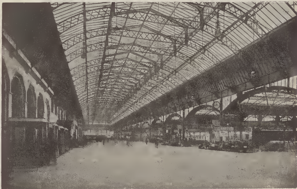
Fig. 3 — Cais de tampo
