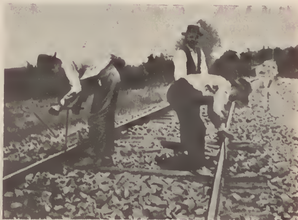
Furação das travessas
