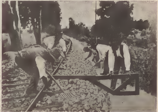
Regularização das banquetas
