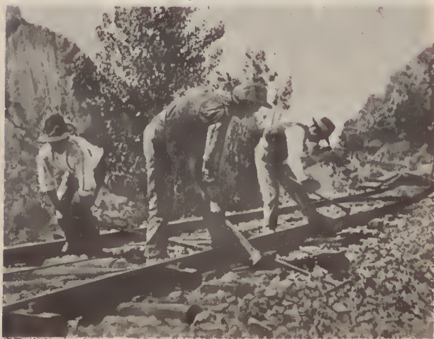
Regularização das superfícies de sabotagem
