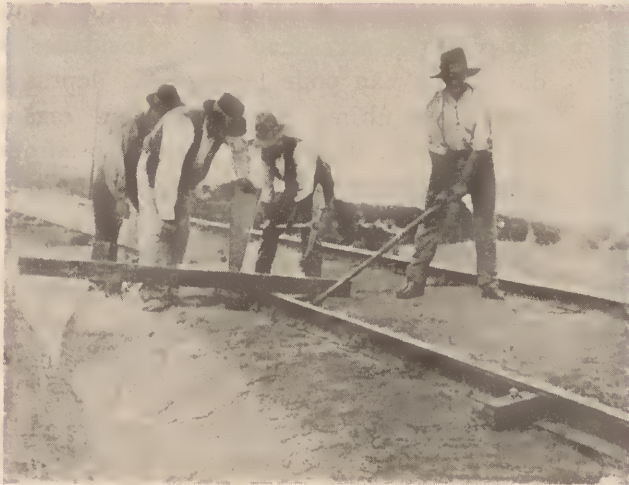
Nivelamento da fila baixa pelas estacas de piquetagem das curvas
