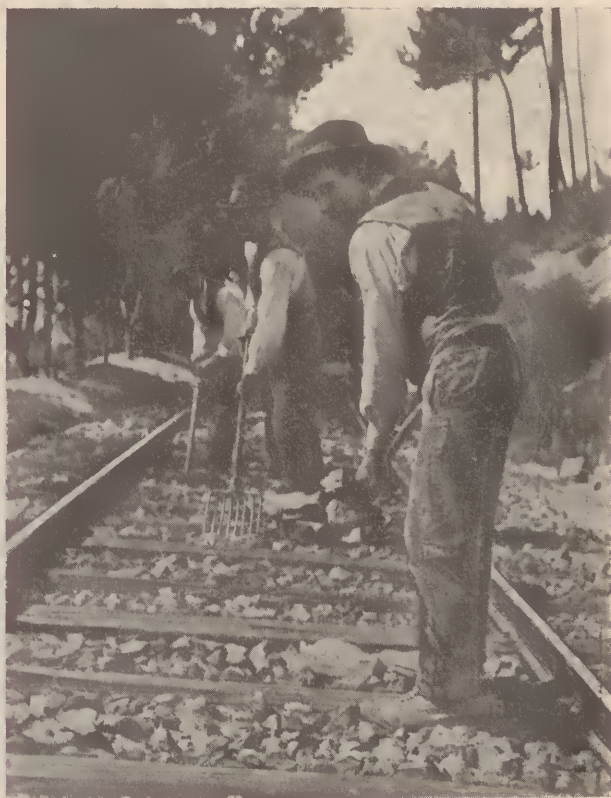
Depuração do balastro por meio de forquilhas
