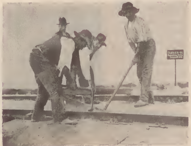
Nivelamento da via em curva
