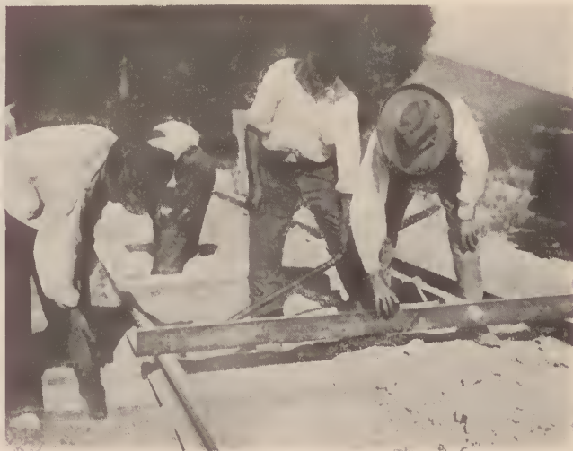
Nivelamento da via em recta
