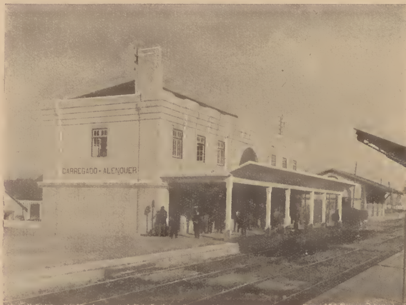
Edifício da estação do Carregado
