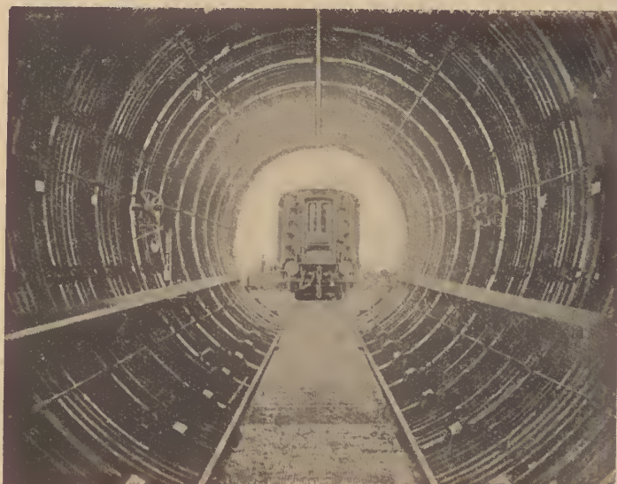
Vista do interior da estufa de desinfecção de carruagens
