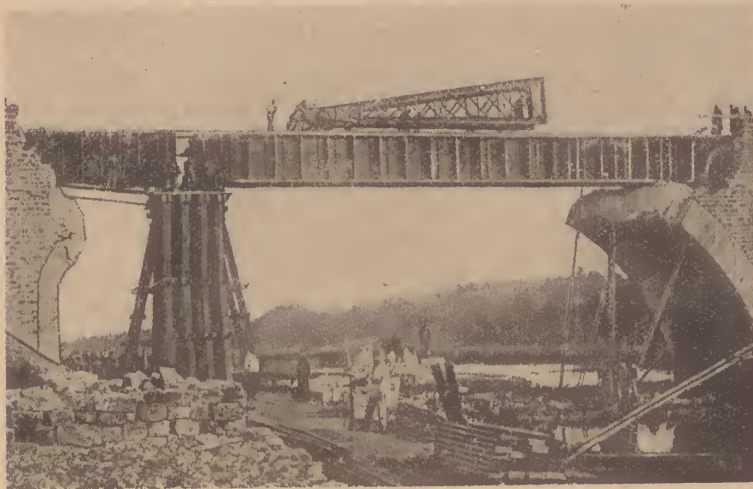
A ponte de Trilport, destruída pelos ingleses na batalha do Marne, quando da Grande Guerra, foi franqueada pouco depois por uma ponte «Marcille» representada na gravura
