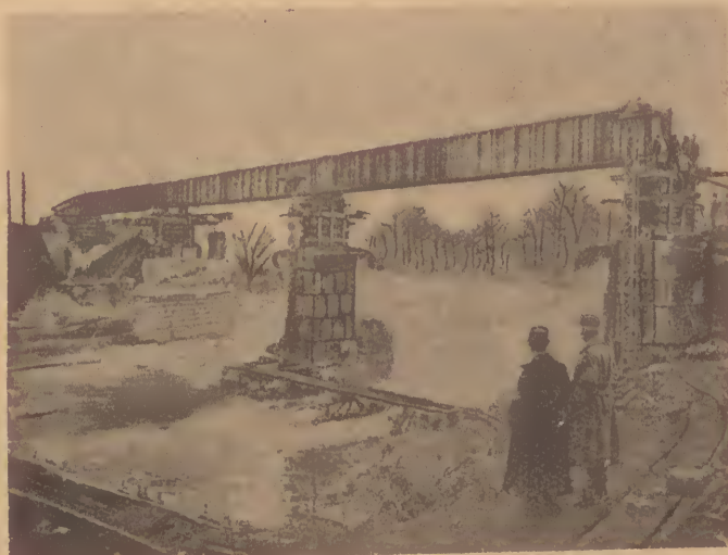
A ponte de Villeneuve, na linha de Soissons a Laon, destruída durante a Grande Guerra foi provisoriamente substituída por uma ponte «Marcille» representada na gravura
