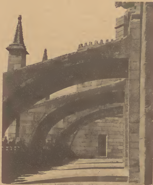
Sé da Guarda — Arcos botantes do lado do Sul
