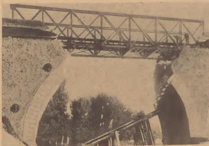
Os ingleses na Grande Guerra, durante a batalha do Marne, destruíram um dos arcos da ponte de Armentières, sobre o Marne, na linha férrea de Paris-Nancy, causando-lhe uma brecha de 17<sup>m</sup>,50 que teve de ser franqueada provisoriamente por uma ponte «Henry» de comprimento de 22<sup>m</sup>,80
