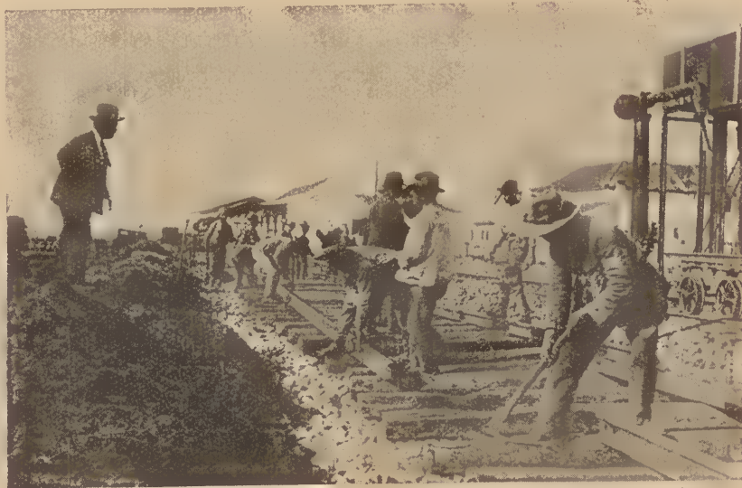
Reparação da linha em Viana do Alentejo
