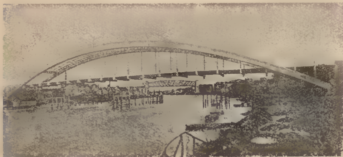
Fig. 10 — Ponte de formigão armado, no Oise (França)
