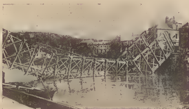
Fig. 11 — Ponte do Creil (França) destruída durante a guerra
