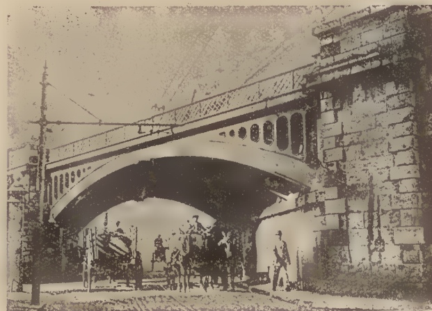
Fig. 6 — Ponte de ferro fundido em Xabregas (Lisboa)
