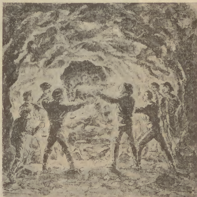
O encontro das 2 galerias de direcção do tunel de S. Gothard em 29 de Fevereiro de 1880
