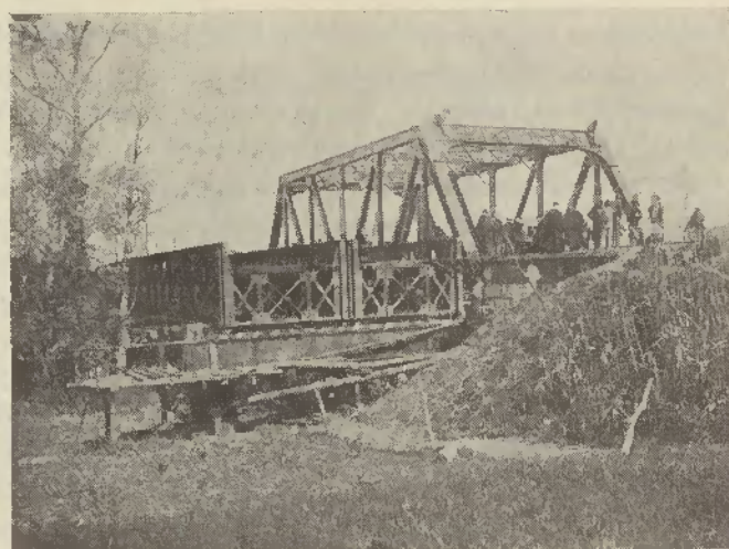
Fase da construção da ponte do Almonda
