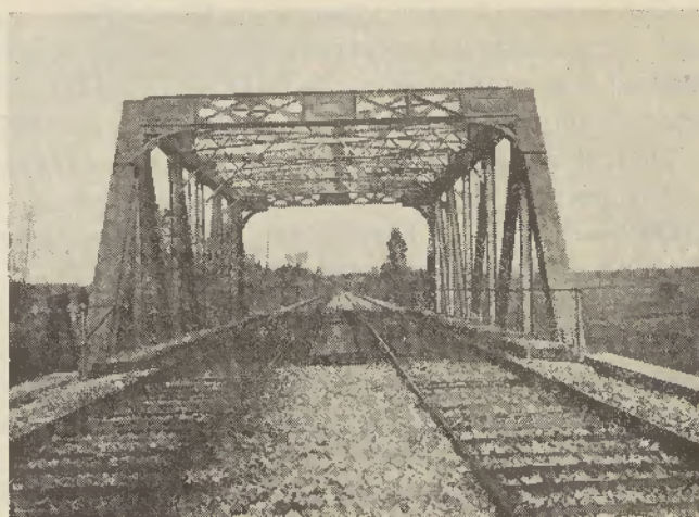
Ponte do Almonda
