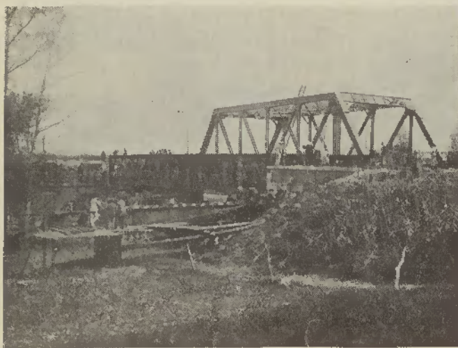
Fase da construção da ponte do Almonda
