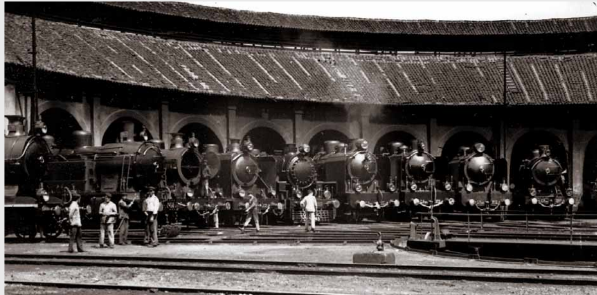
Depósito de locomotivas - Barreiro.
