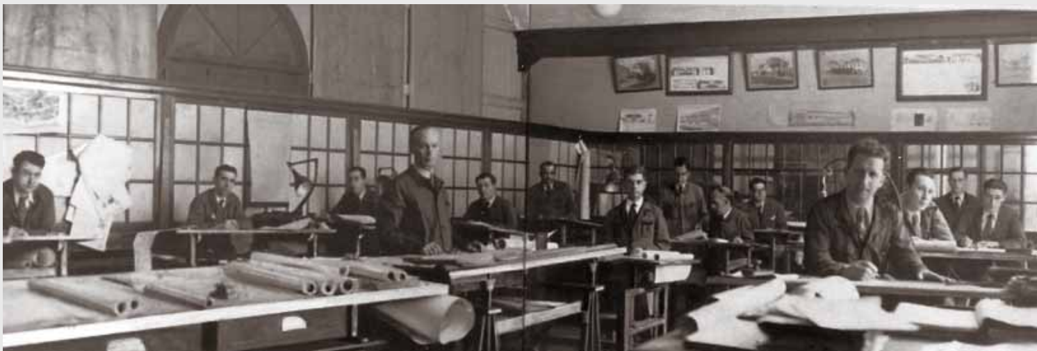
Sala de Desenho do Serviço de Via e Obras da CP - dezº 1958.
